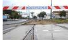
Teljesen leállhat a 2-es villamosvonal építése
