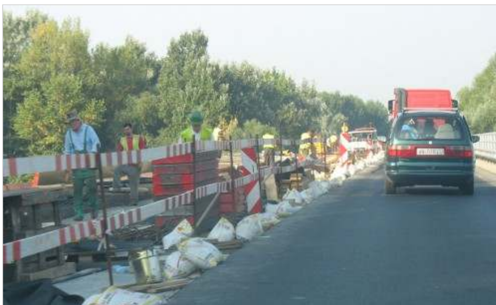
Nyújtott műszakban, bővített létszámmal dolgozik a kivitelező a Tisza-hídon. Szeptember végére felújítva átadják. A szerző felvétele
