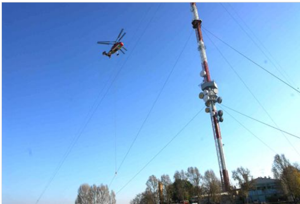
Rögzítik az új antennát a torony tetején. Fotó: Tésik Attila
